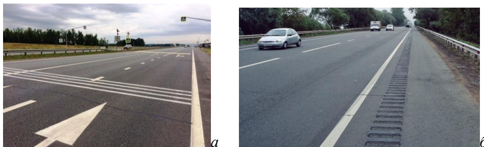
Рис. 3. Поперечные (а) и продольные (б) шумовые полосы
