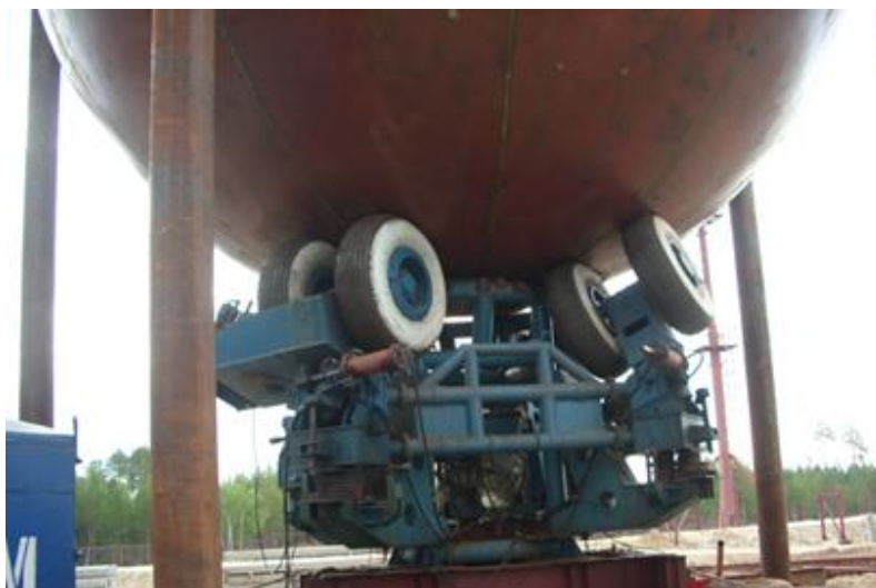
Рис. 2. Монтаж сферического резервуара при помощи манипулятора-вращателя
