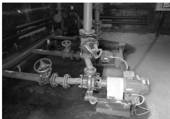
Рис. 1. Повысительная насосная станция
