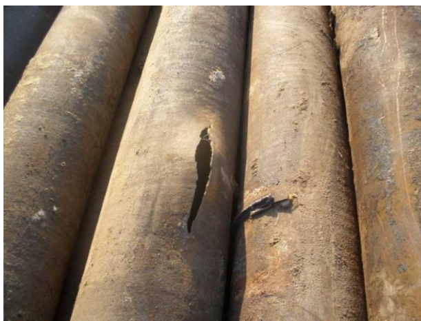
Рис. 1. Коррозионное разрушение трубы
