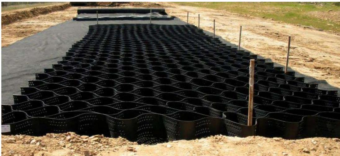
Рисунок 1. Общий вид конструкции гидроизолированной грунтовой подушки
