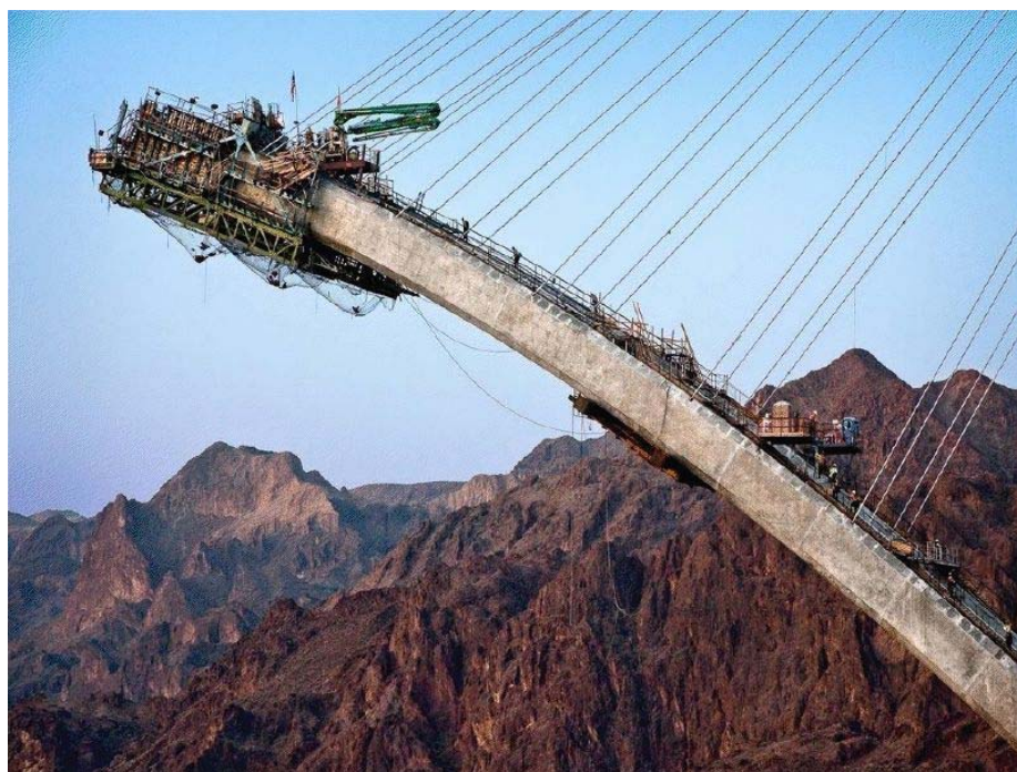
Рисунок 2. Применение временных вант
