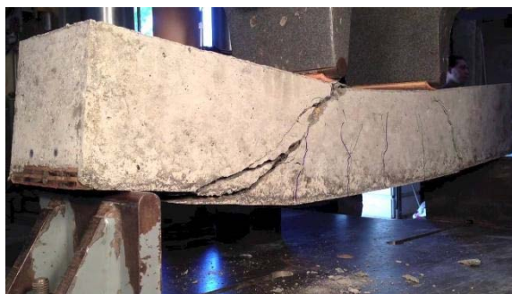
Рисунок 1. Образование трещин у железобетонной балки при испытании на изгиб
