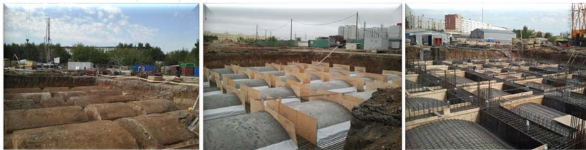
Рисунок 1. Ленточно-оболочечный фундамент
