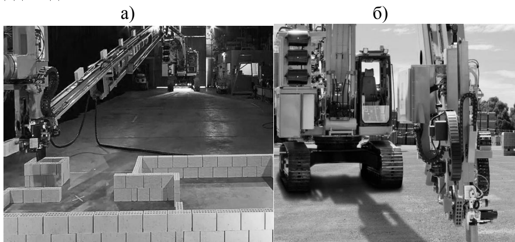
Рисунок 2. а) процесс работы робота; б) робот «Hadrian X».
