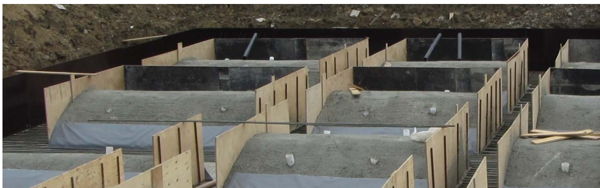
Рисунок 4. Установка опалубки
