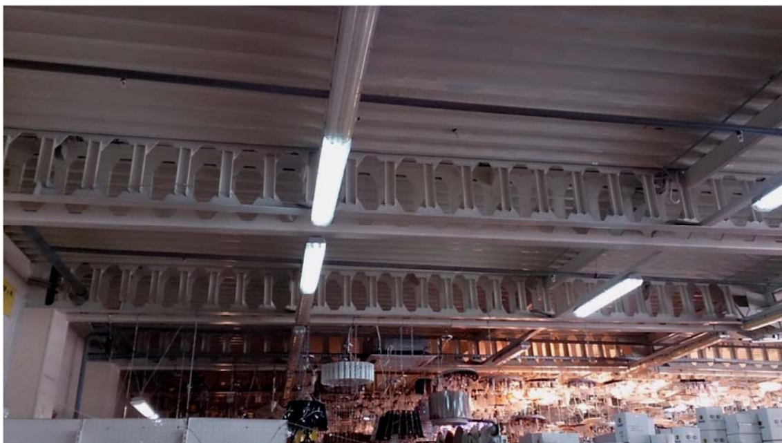
Рисунок 2. Перфорированная балка сложного составного сечения
