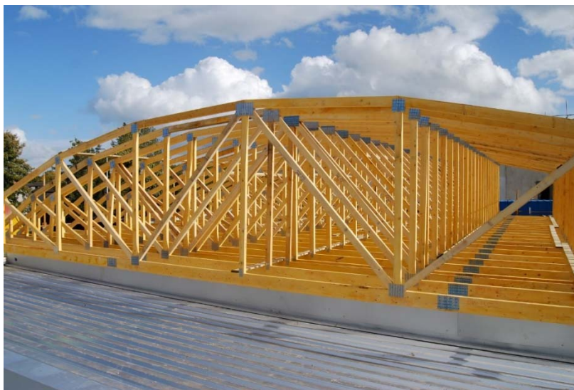
Рисунок 1. Деревянная конструкция с соединениями на МЗП
