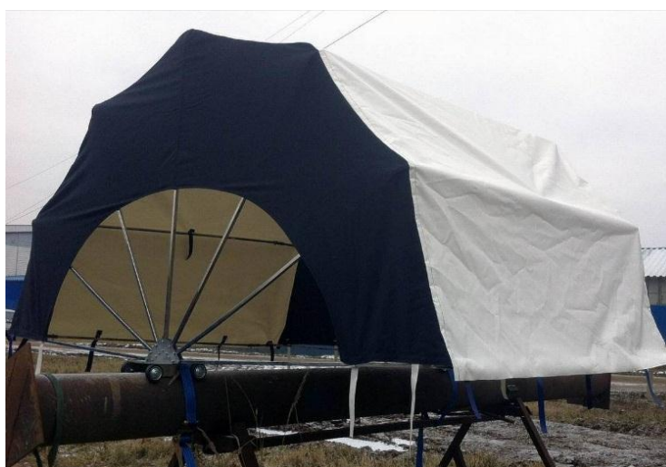
Рис. 1. Защита рабочего места сварщика
