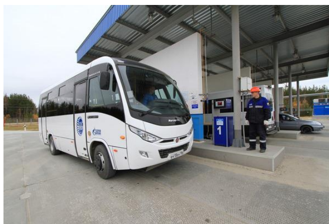
Рис. 2 Автомобильная газонаполнительная компрессорная станция
