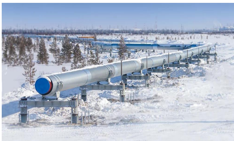
Рис. 1 – Надземная часть нефтепровода «Заполярье - Пурпе»
