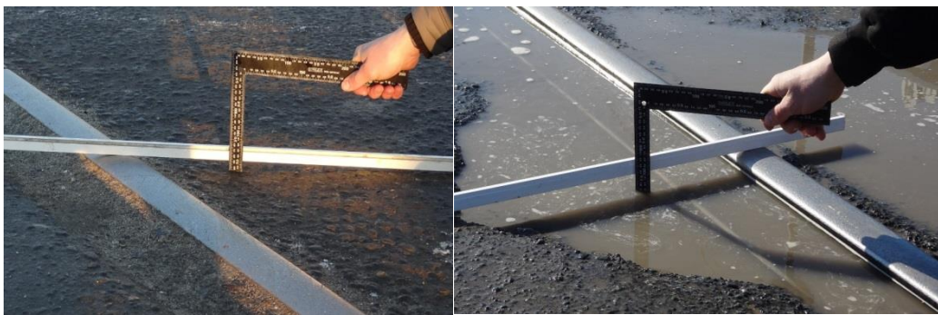
Рисунок 3. Состояние дорожного покрытия на железнодорожном переезде по улице Тимофея Чаркого в октябре 2018 года (слева) и в марте 2019 года (справа).
