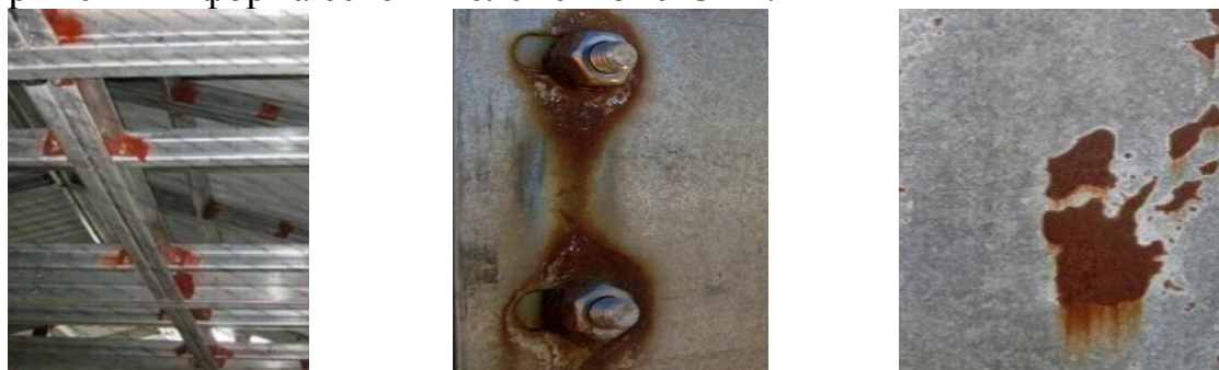
Рисунок 1. Коррозия ЛСТК
