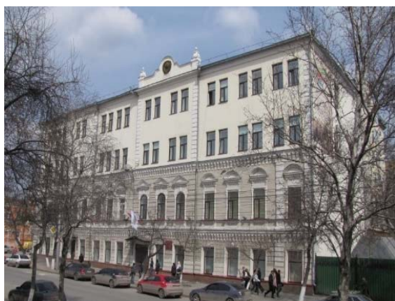
Рисунок 1. Здание в г. Тюмень
