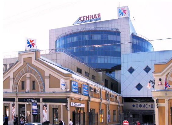
Рисунок 8 – Здание ТК «Сенная» в Санкт-Петербурге
