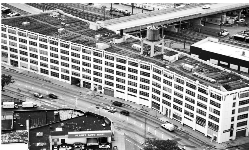
Рисунок 4 – Экологическая ферма Brooklyn Grange на крыше офисного здания. Нью-Йорк, США
