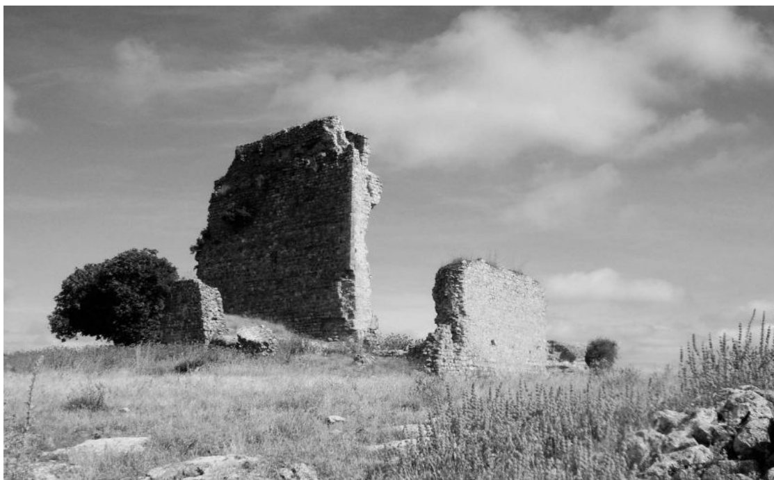
Рисунок 1 – Замок Матрера. Исходное состояние
