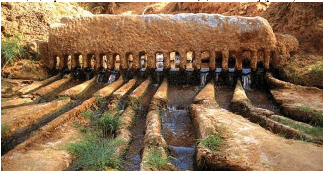
Рисунок 1 – Древний водораспределитель у выхода кяриза на поверхность
