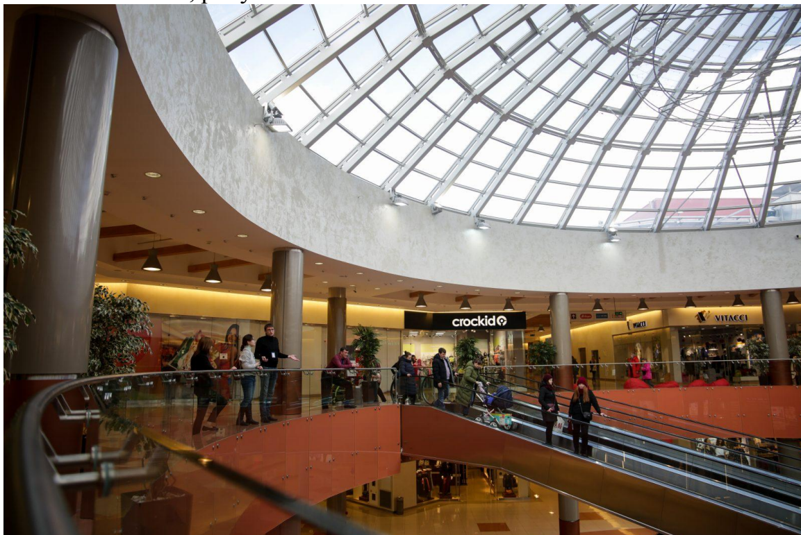
Рисунок 1 – Устройство дренчерных завес в многофункциональных зданиях с атриумами для деления здания на противопожарные отсеки
