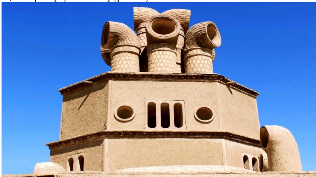
Рисунок 3 – Ветроуловители Ирана – выразительные архитектурные средства, позволяющие улучшить среду обитания человека
