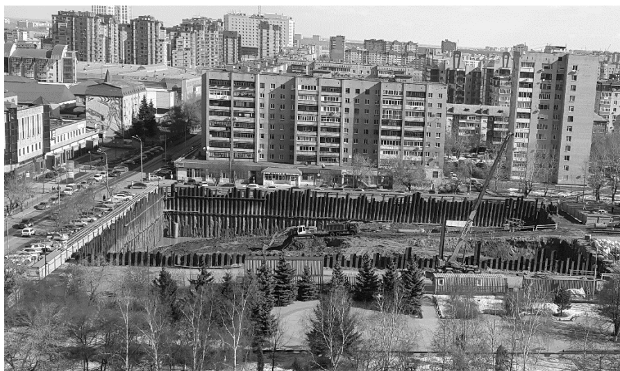
Рис. 1. Устройство подземного паркинга в стесненных условиях (г. Тюмень)
