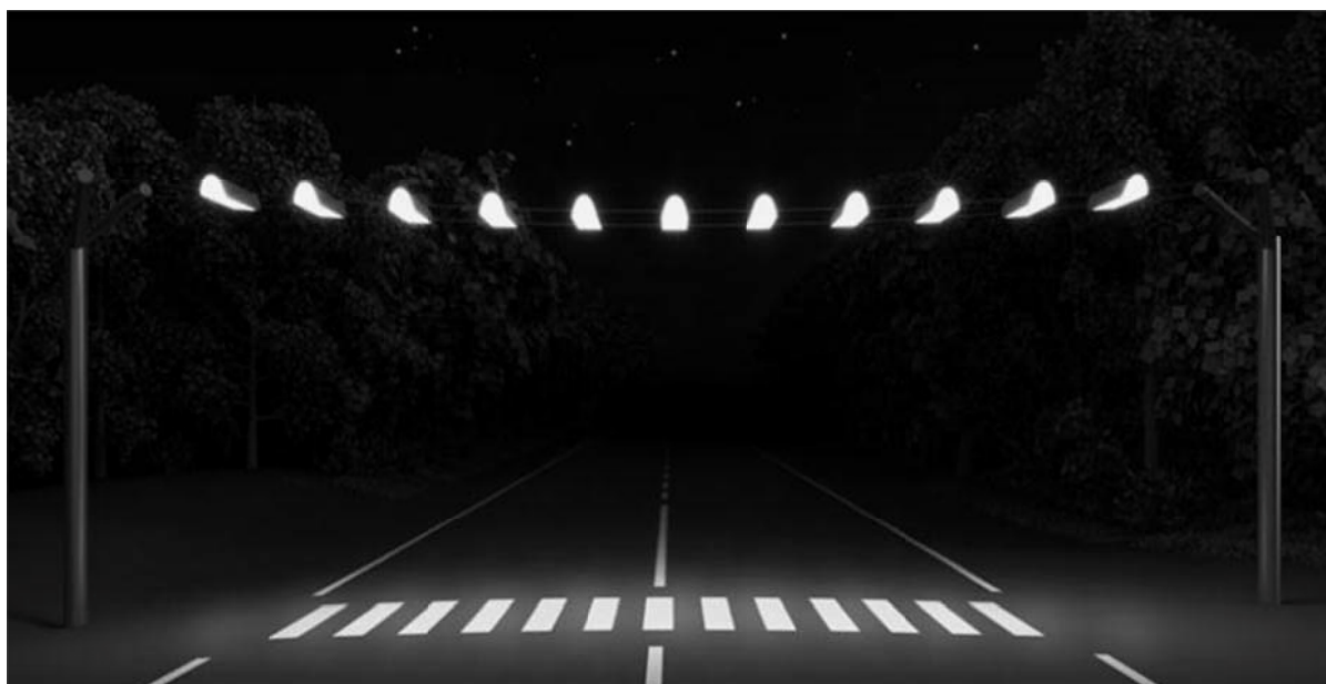
Рис. 3. Лампы освещения пешеходного перехода
