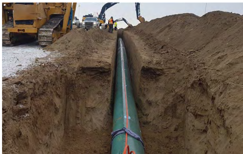
Рисунок 3. Укладка трубопровода с закреплённым оптоволоконным кабелем чувствительного элемента
