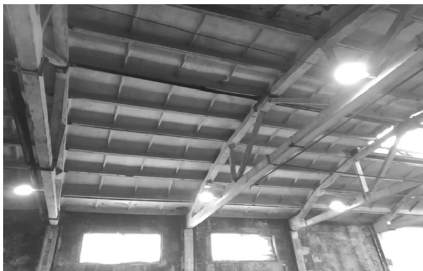
Рис. 1 – Общий вид стропильных ферм
