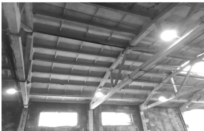
Рис. 1 – Общий вид стропильных ферм
