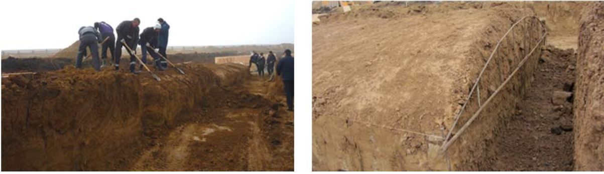
Рис. 2 – Ручная планировка основания с криволинейной цилиндрической поверхностью в пролетной части фундамента
