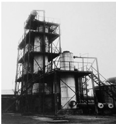
Рисунок 4. Установка В. Г. Шухова для термического крекинга нефти
