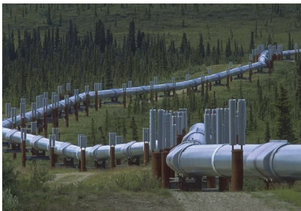
Рисунок 1 – Наземный магистральный трубопровод
