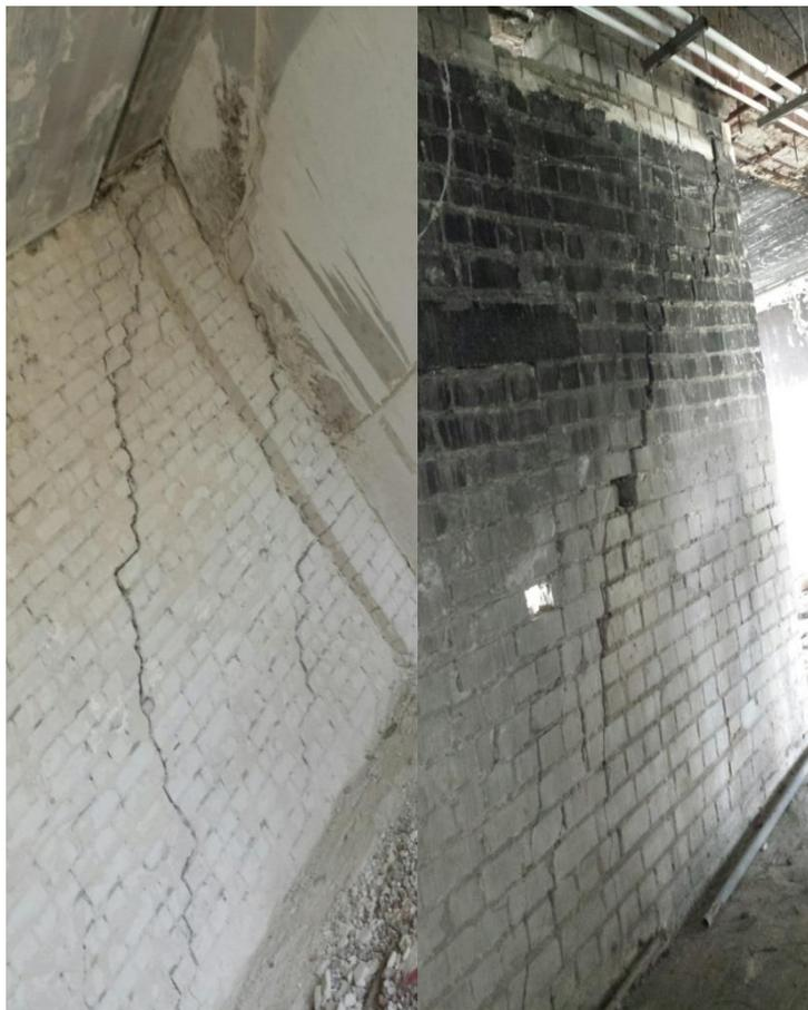
**Рис. 2. Деформационные трещины от просадки фундамента. (Автор)**
