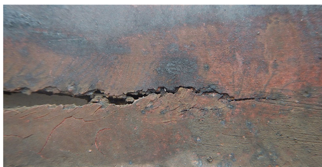
Рисунок 2 – Вид повреждения с внутренней поверхности фланца
