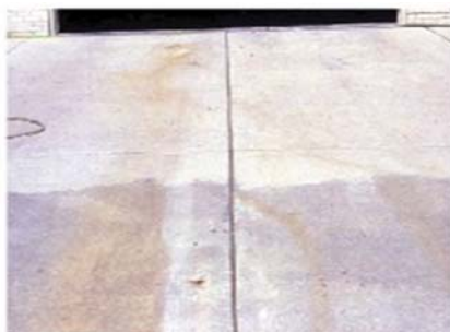
Рисунок 2. Выцветивание бетона
