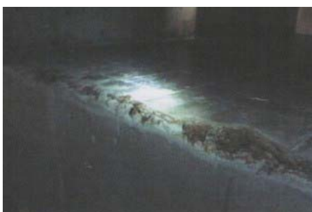
Рисунок 6. Наплывы бетона
