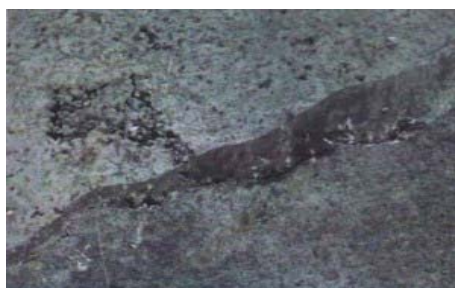
Рисунок 5. Косослой бетона
