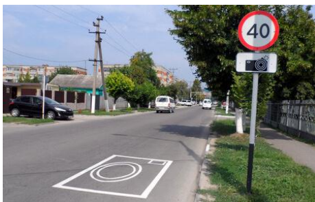
Рис. 3. Обозначение места с фото видео фиксацией нарушений ПДД
