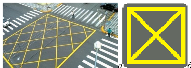
Рис. 4. Обозначение перекрестка разметкой (а) и знаком (б), на который запрещается выезжать, если впереди образовался затор
