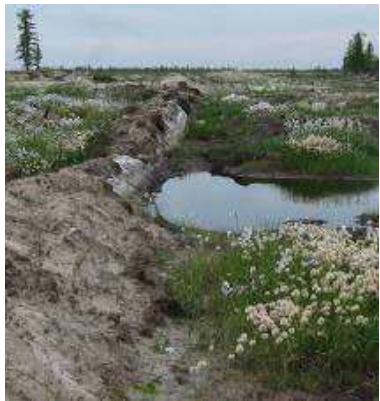
Водная эрозия обвалования ПК 24+40 – ПК 24+74
