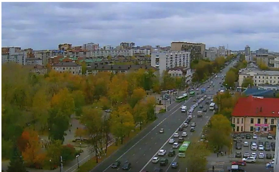
Рис. 1. «Карман» для канализирования левоповоротного транспортного потока с недостаточной длиной
