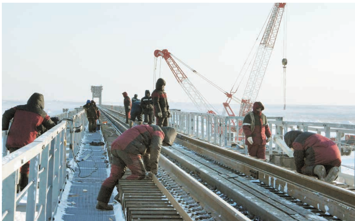
Строительство моста через реку Юрибей, самого длинного моста в мире за Полярным кругом
