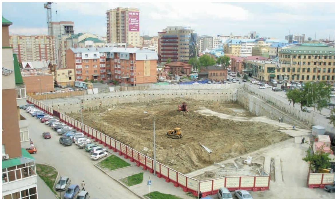
Устройство подземной части автомобильной стоянки по технологии «стена в грунте», г. Тюмень
