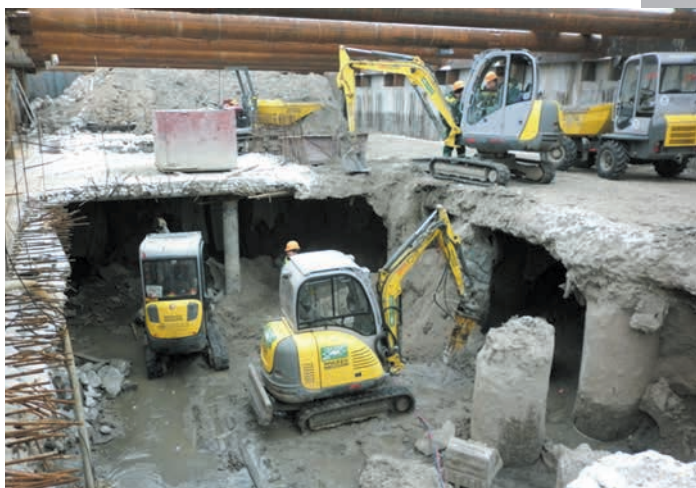
Разработка грунта при строительстве методом «сверху-вниз»
