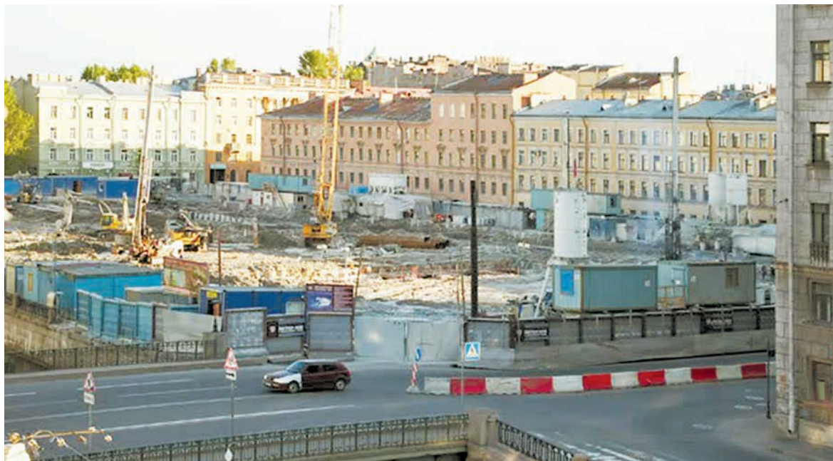
Строительство подземной части комплекса зданий в Санкт-Петербурге
