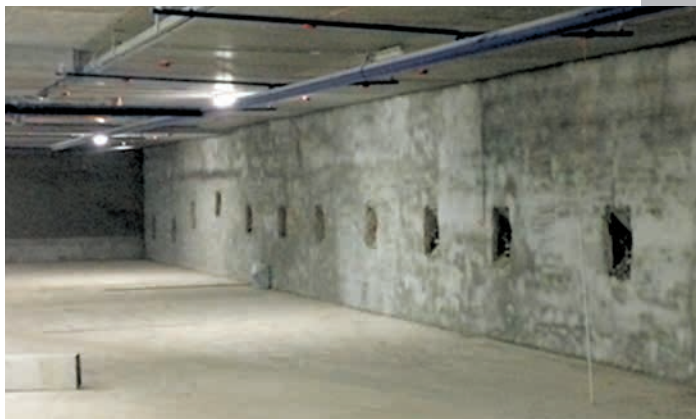
Подземная стоянка, огражденная конструкциями, выполненными по технологии «стена в грунте»
