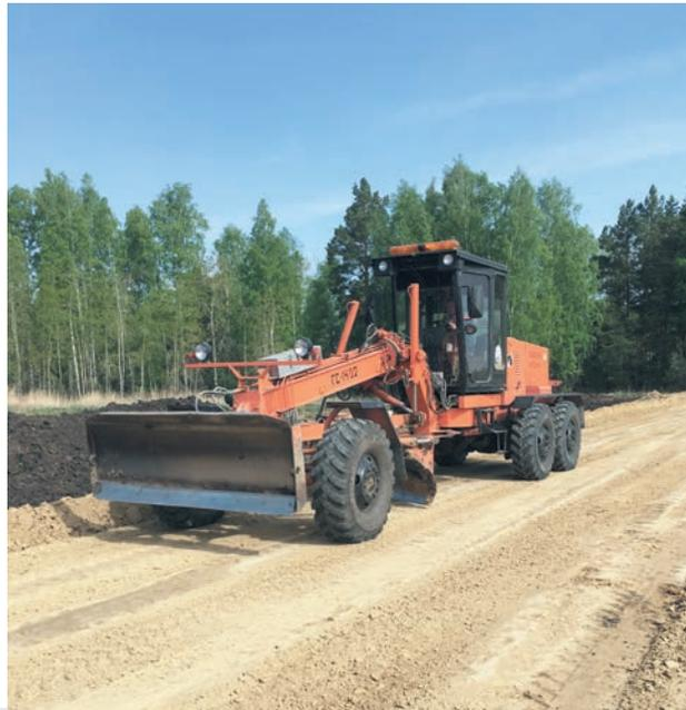
*Инженерная подготовка площадки для жилищного строительства в мкр. Южном Заводоуковска. Устройство земляного полотна*
