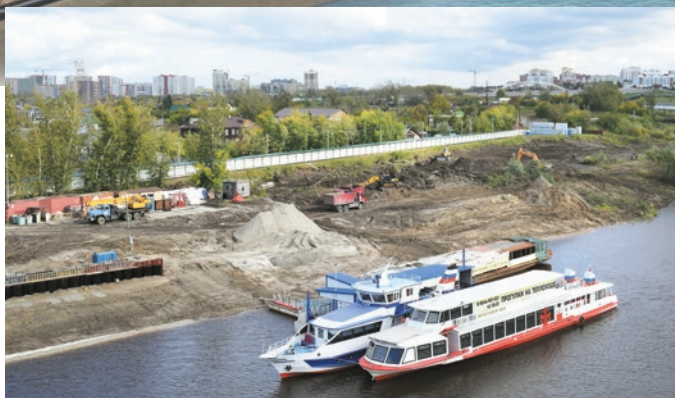
Строительство уже началось
