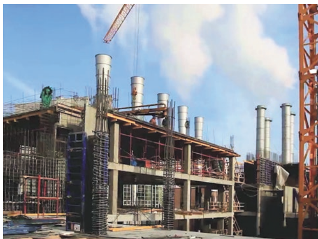
Рис. 7. Работы по устройству надземной части здания
