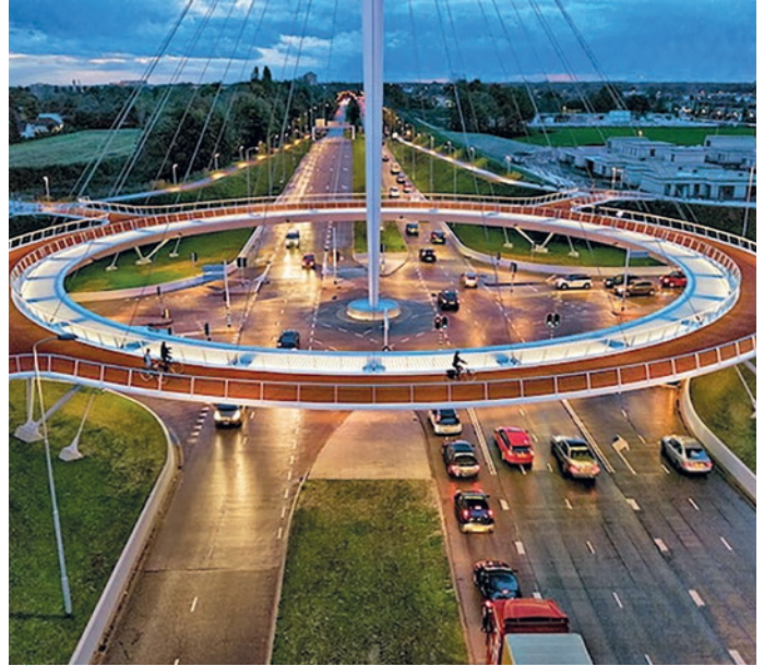
▲ Кольцевой велосипедный мост в Голландии напоминает карусель, у которой к центральной мачте – пилону высотой 70 метров – прикреплены 24 вант-троса, к ним подвешено металлическое пролетное строение весом 1000 тонн. Мост, по сути являющийся подвесной велосипедной дорожкой, подвешенной над кольцевой автомобильной развязкой, позволил устранить дорожные пробки и заторы, обеспечить безопасность перемещения велосипедистов, которые особенно уязвимы на проезжей части.
