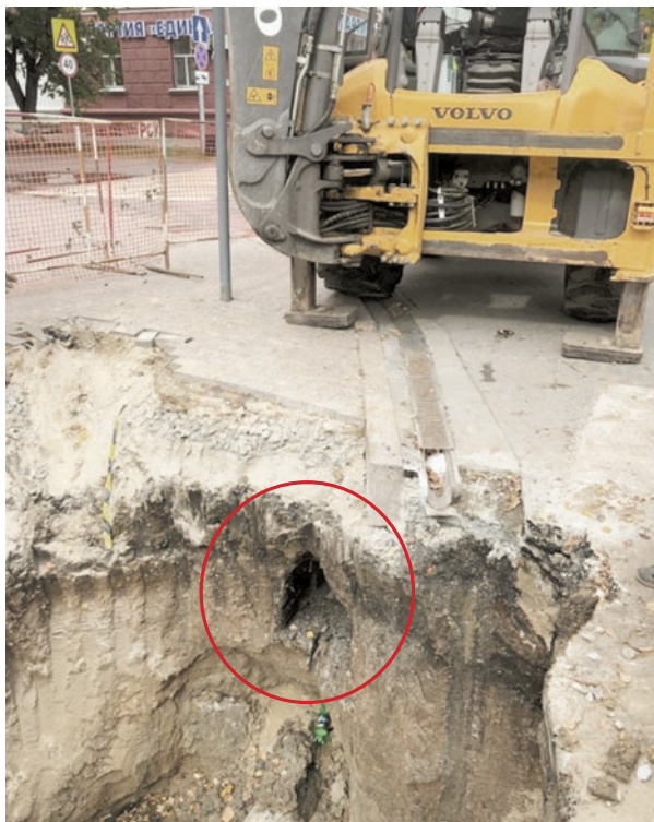
Фрагмент деревянной трубы, найденной во время ремонтных работ на улице Водопроводной
