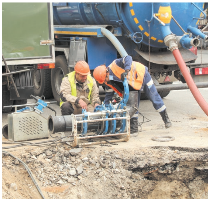
Завершающий этап работ по замене магистрального водовода на улице Водопроводной
