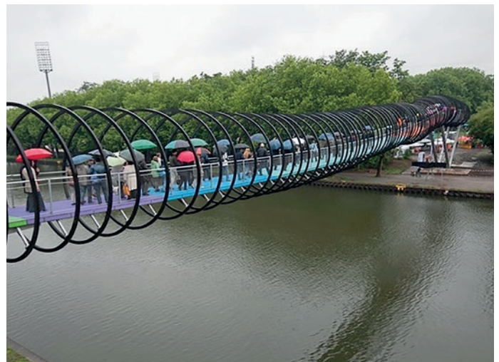
▲ Пешеходный мост (Slinky Springs) в Германии представляет собой большую спиральную пружину, состоящую из 496 металлических колец толщиной 9 сантиметров, перекинутую через Рейн до одного из островов посредине реки.
