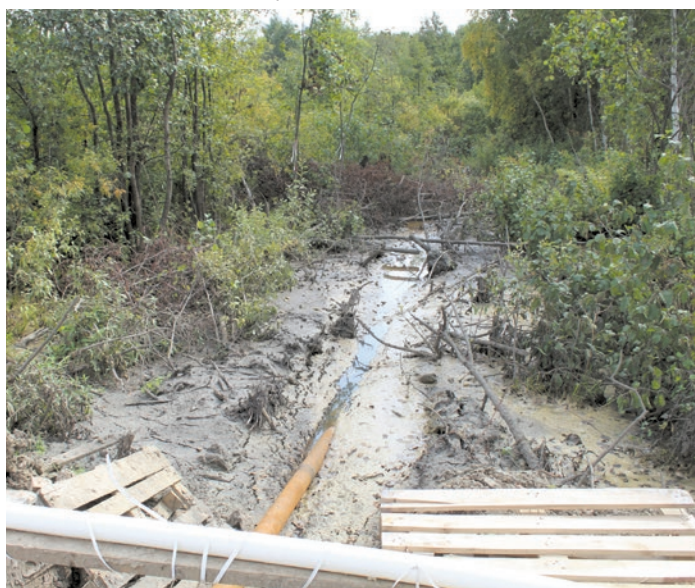
Нитку водовода строят прямо под болотом
