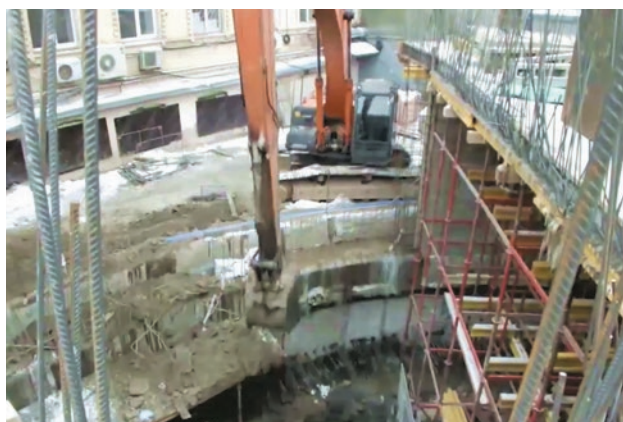
Рис. 6. Экскавация грунта на поверхность
