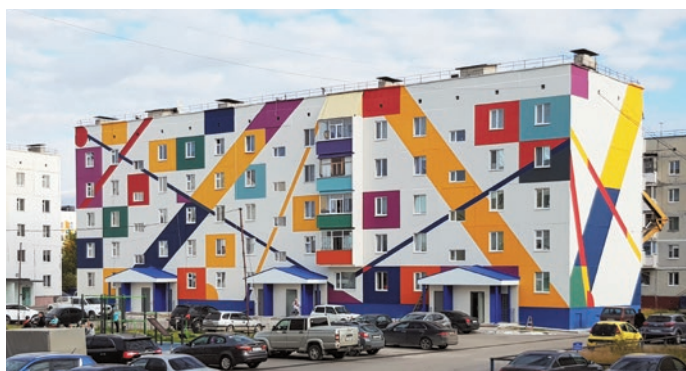
Жилые дома в г. Муравленко после капитального ремонта
