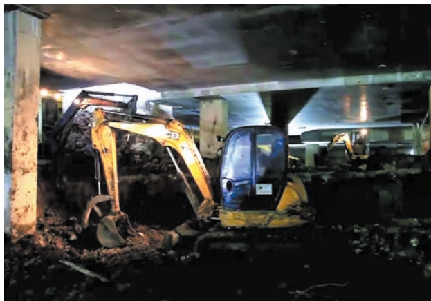
Рис. 5. Экскавация грунта на минус втором уровне малогабаритной техникой
