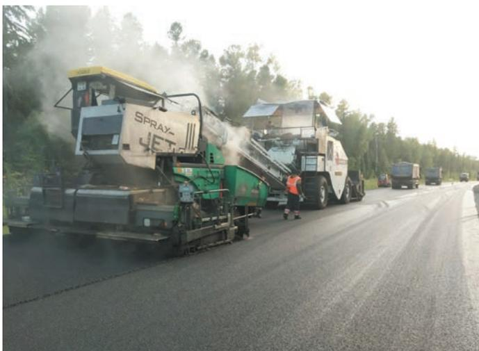
*Использование перегружателя асфальта при производстве работ позволяет улучшить качество смеси*
