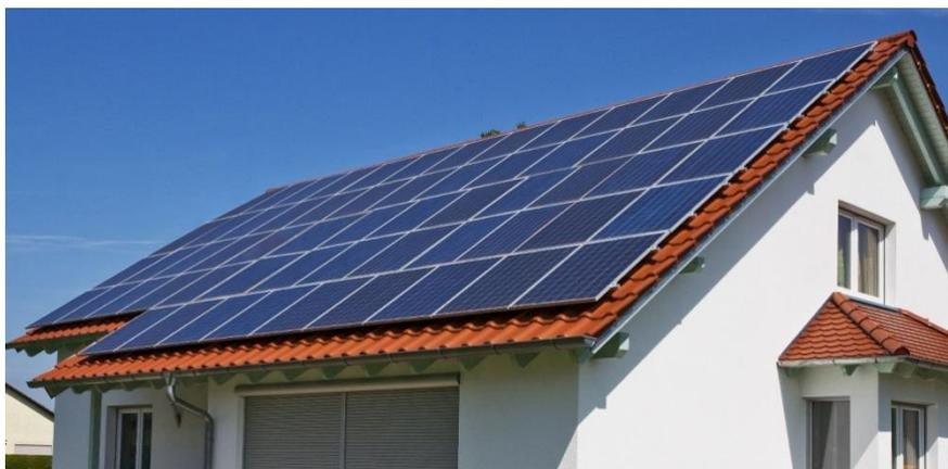
Рис. 3.3. Фотоэлектрические модули
