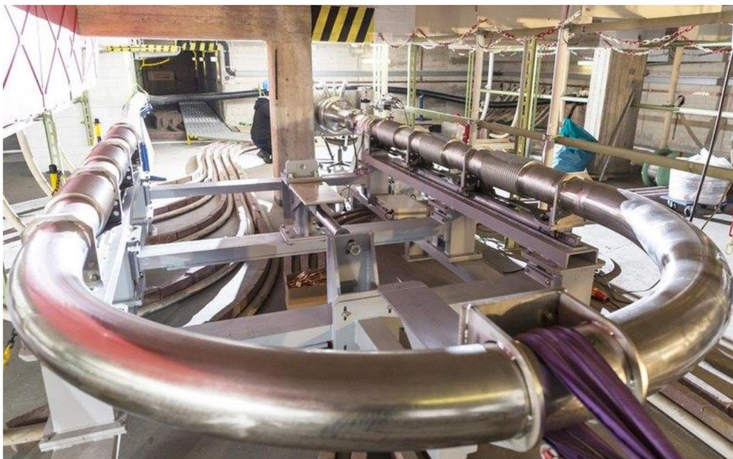
Рис. 3.4. Фрагмент ЛЭП на основе сверхпроводников
