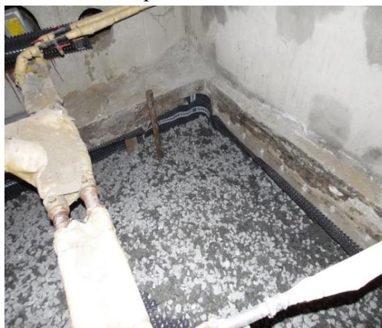
**Рисунок 4.9.** Укладка щебеночного слоя толщиной 100 мм
