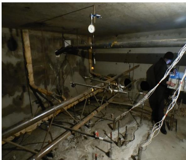
**Рисунок 4.12.** Установка в проектное положение оболочки и инъекторов
