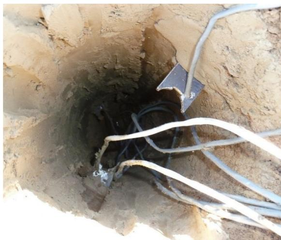
**Рисунок 4.7.** Проектное положение внедренных мессдоз
