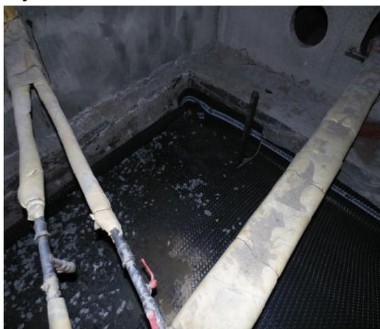
**Рисунок 4.8.** Профилированная мембрана «Planter»
