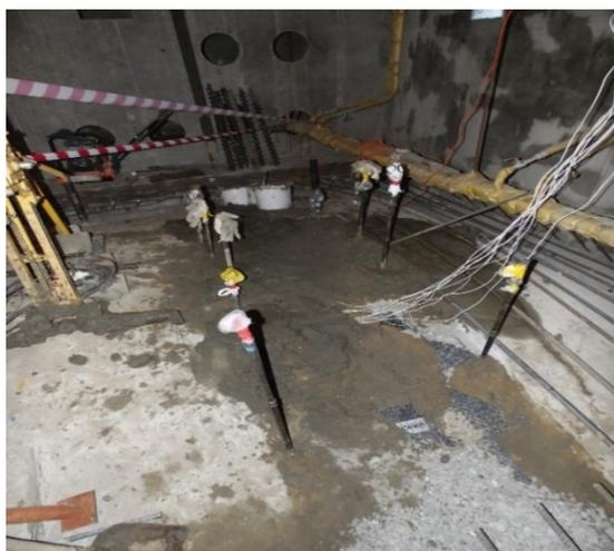
**Рисунок 4.10.** Установка глубинных марок перемещения в проектное положение
