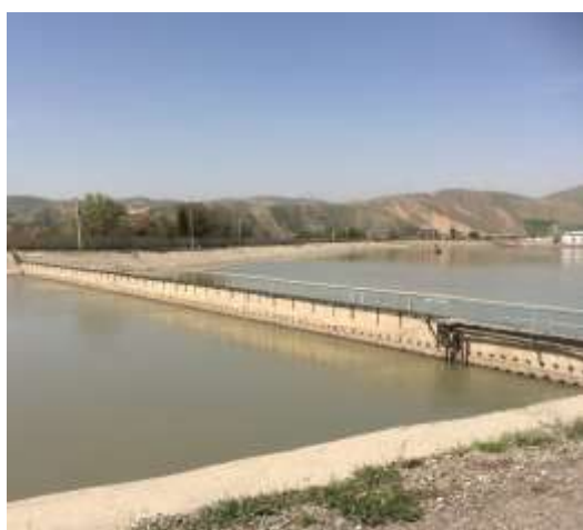
Рисунок 3. Первая ступень очистной станции самотечного водопровода – бассейн суточного регулирования (г. Душанбе)
