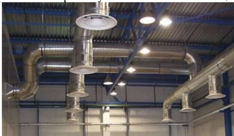
Рисунок 2. Пример системы общеобменной вентиляции
