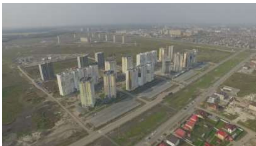
Рисунок 2. Строительство новых микрорайонов за чертой объездной дороги в г.Тюмени
