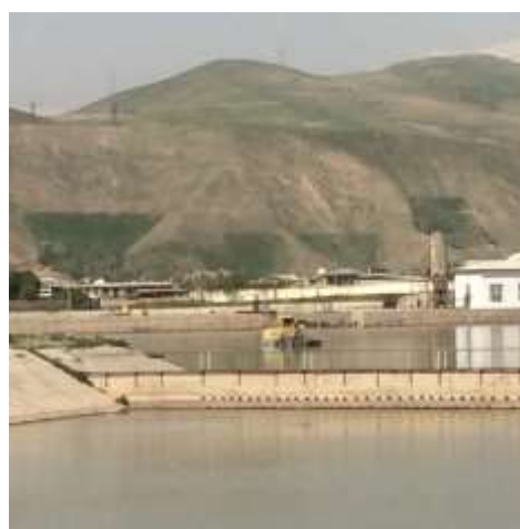
Рисунок 3. Первая ступень очистной станции самотечного водопровода – бассейн суточного регулирования (г. Душанбе)
