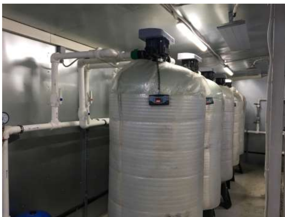
Рисунок 2. Пример блочной станции водоочистки заводского изготовления
