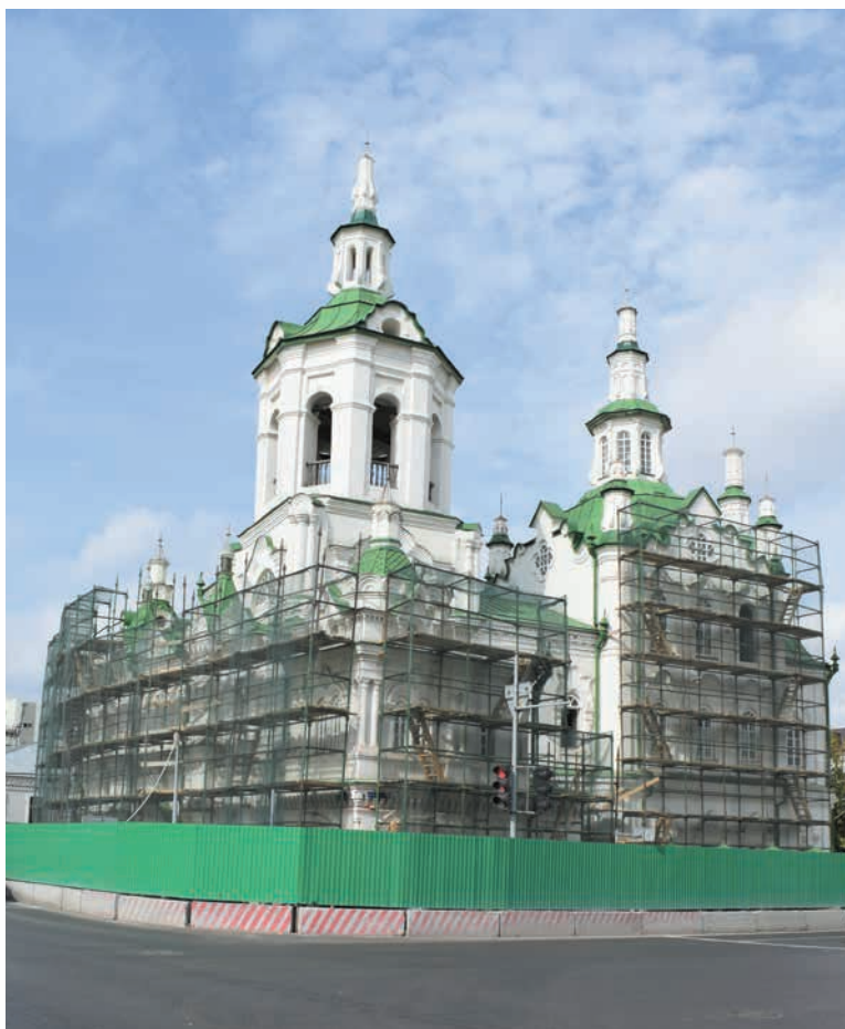
Завершить реставрационные работы на объекте планируется в 2021 году
