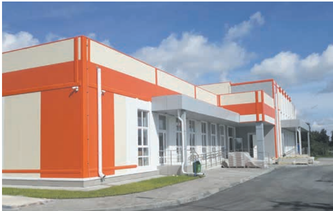
Строительство школы искусств в с. Киево на заключительном этапе
