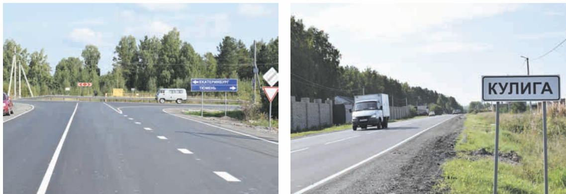
Ремонт дороги Каменка – Успенка выполнен в рамках национального проекта «БКАД»
