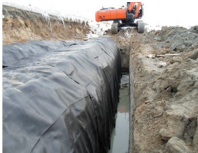
Наблюдение в естественных условиях за состоянием экспериментального участка автомобильной дороги Сургут – Салехард и реализованными схемами стабилизации земляного полотна и основания
