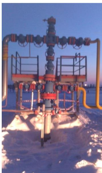
Рисунок 2 – Пример смещения ФА при потере продольной устойчивости крепи скважины и появлении эксцентриситета эксплуатационной колонны
