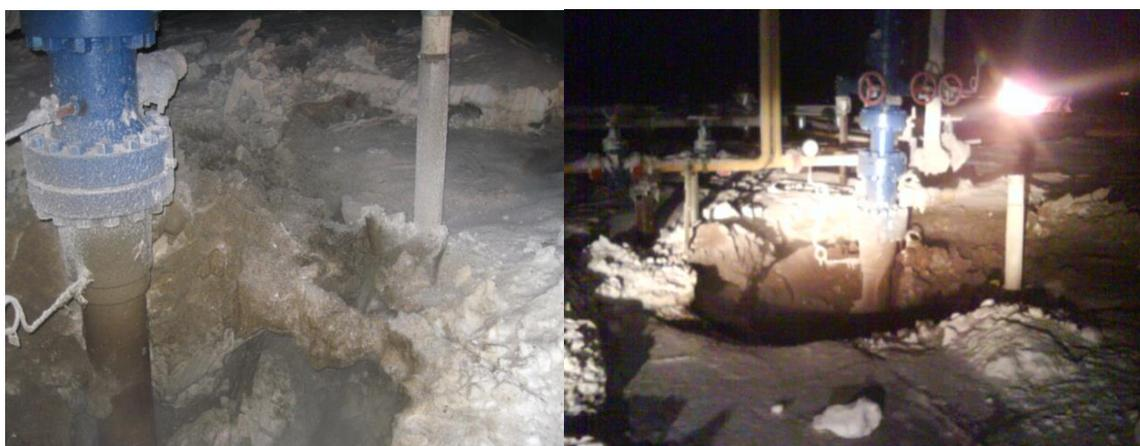
Рисунок 1 – Примеры воронок и провалов устья скважин
