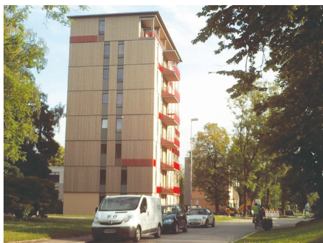
Рис. 6. Восемьэтажный деревянный жилой дом. Бад-Айблинг, Германия [12]
