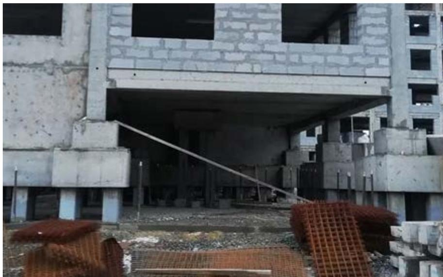
Рисунок 1 – Здание на этапе строительства на сваях с общей стеной
