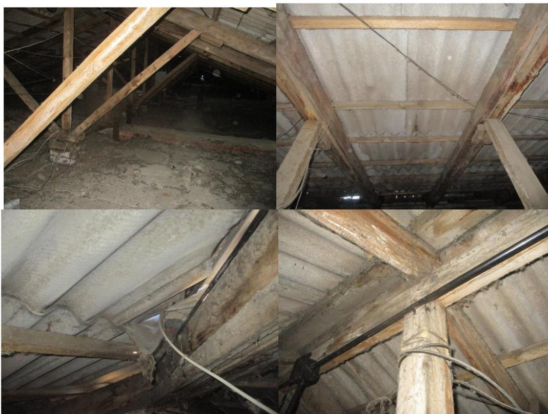
Рисунок 3 – Фотофиксация конструкций кровли первого объекта
