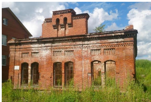
Рисунок 1.4. – Фото главного фасада здания электростанции (2010-е гг.)
