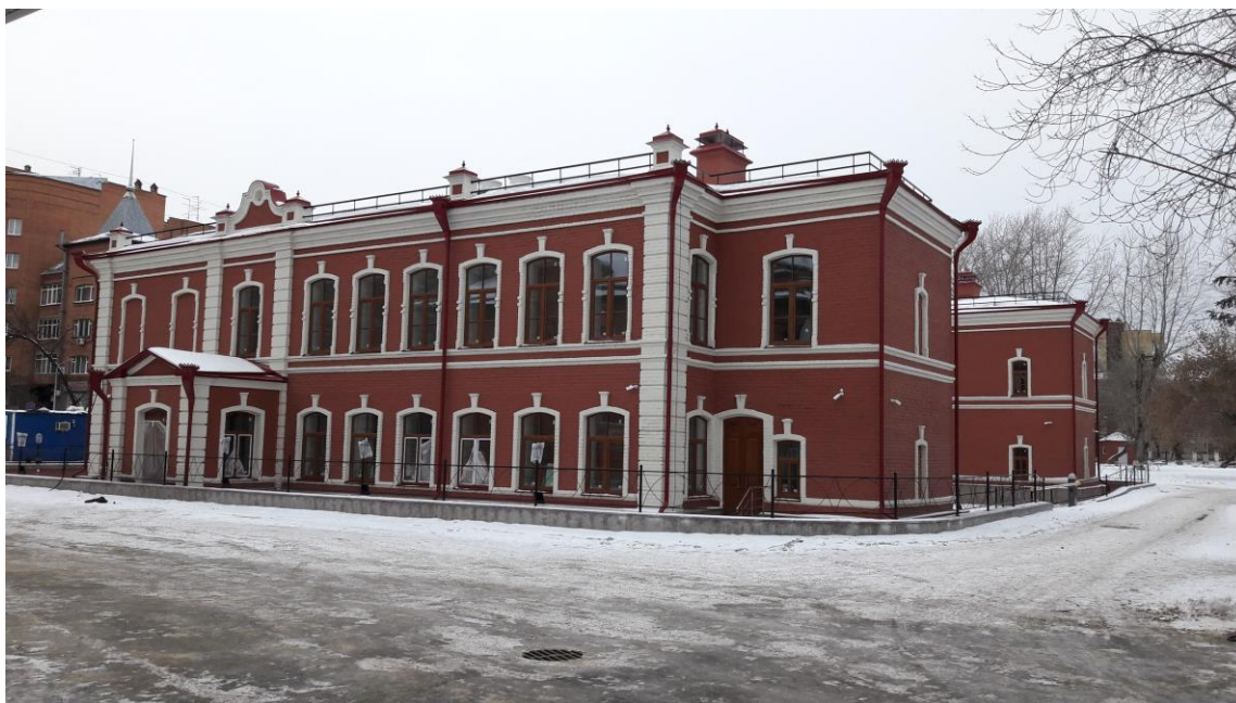
Рисунок 9 – Здание больницы после реконструкции (ул. Даудельная, 5)
