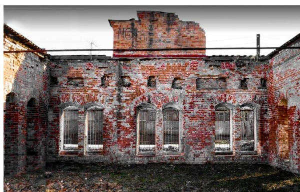
Рисунок 1.2. – Фото руинированного здания электростанции (2010-е гг.)
