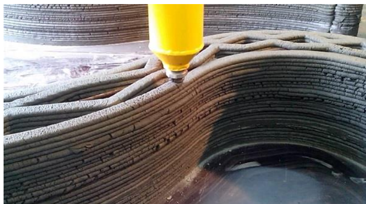
Рисунок 1 – Послойное нанесение смеси 3D принтером
