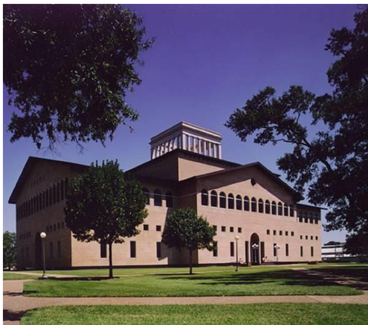
Рисунок 4 – Здание архитектурного колледжа в Хьюстоне, Филип Джонсон
