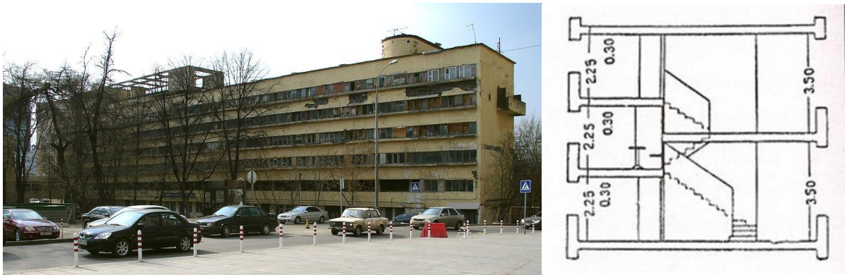
Рисунок 1 – Дом Наркомфина в Москве. Устройство с ячейками типа F
