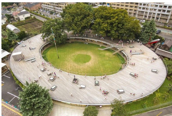
Рисунок 1 – Fuji Kindergarten. Вид на благоустроенную крышу
