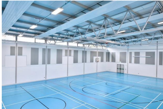
Рисунок 8 – Звукопоглощающие стеновые панели Akusto Wall компании Ecorphon в средней образовательной школе Rainey. Великобритания, Марафелт
