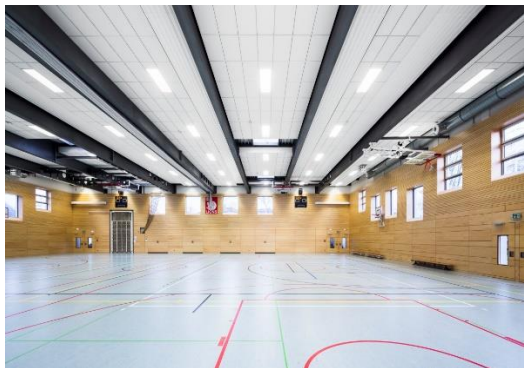
Рисунок 7 – Ударопрочный потолок Super G Plus компании Ecorphon, использованный в международной школе. Германия, Дюссельдорф
