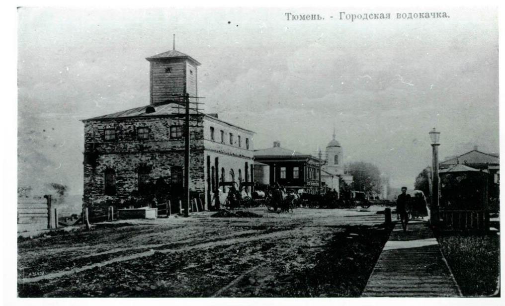
Рисунок 6 – Городская водокачка, г. Тюмень
