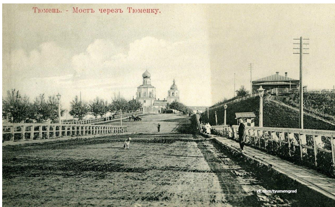
Рисунок 1 – Мост через реку Тюменку
