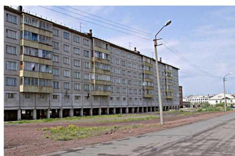
Рисунок 1 – Многоквартирный дом на сохранённом мерзлом грунте
