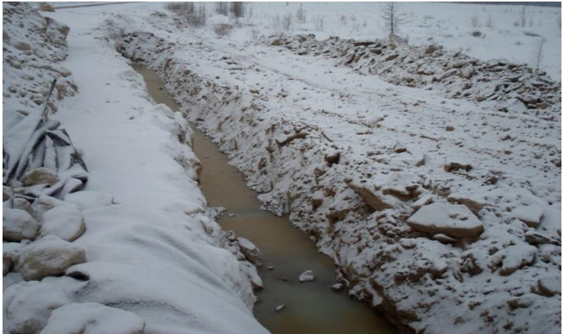
Рисунок 2.17 – Скопление (застой) воды в технологической траншее
