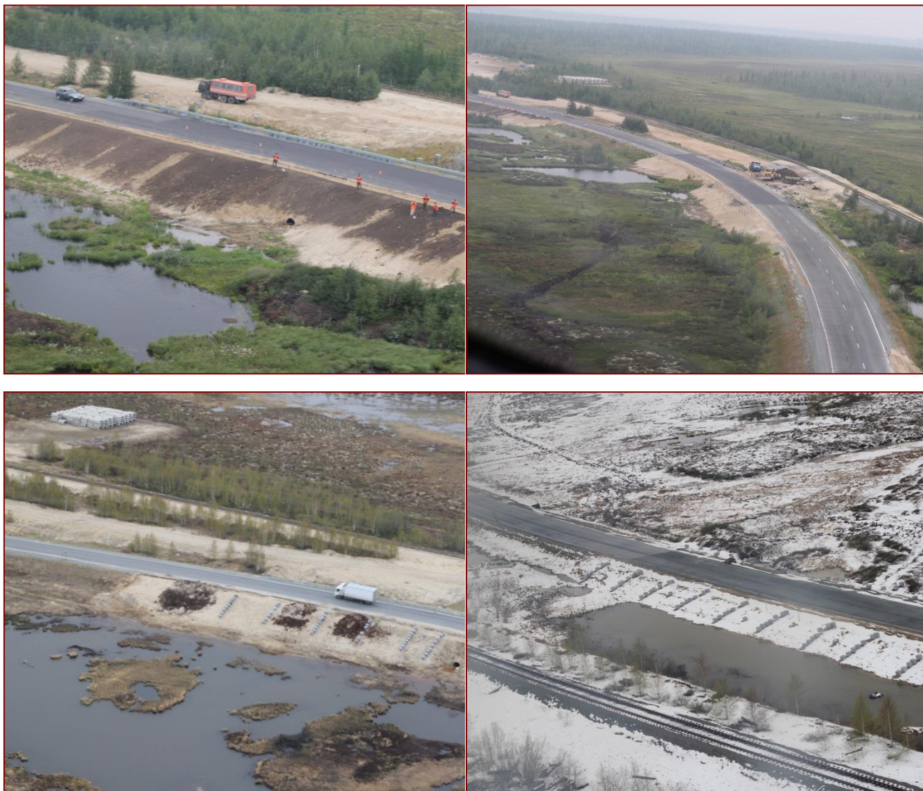
Рисунок 2.2 – Общий вид рассматриваемого участка автомобильной дороги
