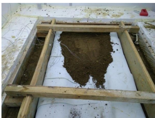
Рисунок 4.26 – Устройство опалубки и отсыпка грунта при возведении насыпи ЗП автомобильной дороги
