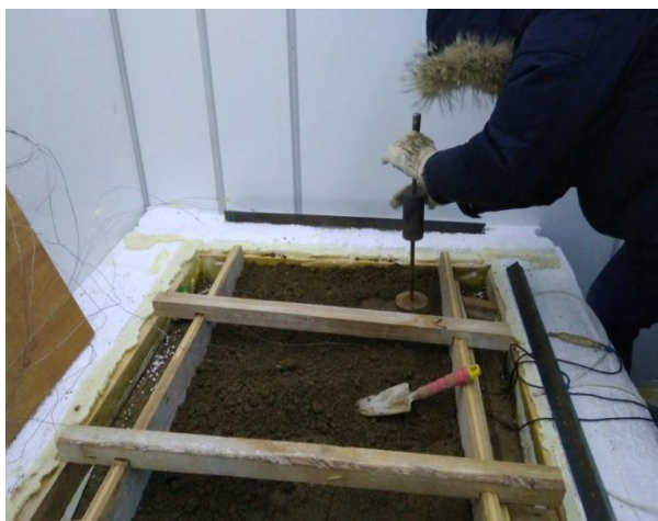
Рисунок 4.16 – Уплотнение грунта ЗП автомобильной дороги
