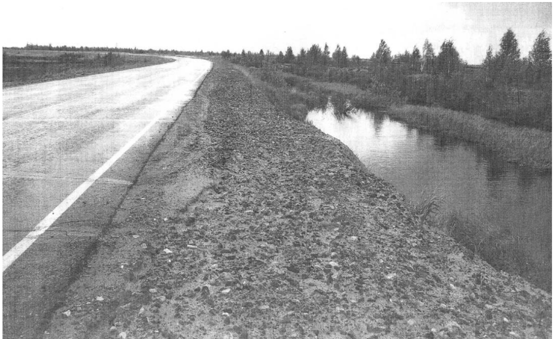
Рисунок 2.4 – Вид рассматриваемого участка автомобильной дороги п. Пангоды (км 877+210) – п. Правохеттинский (км 877+300), ПК 594+00 – ПК 594+90
