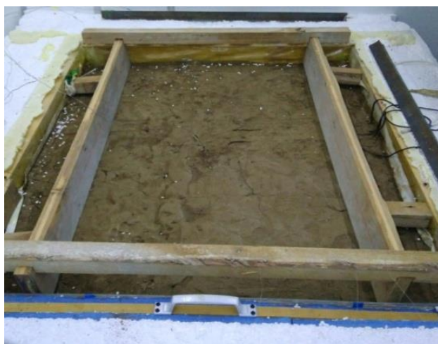
Рисунок 4.14 – Устройство опалубки для соблюдения геометрических пропорций ЗП автомобильной дороги
