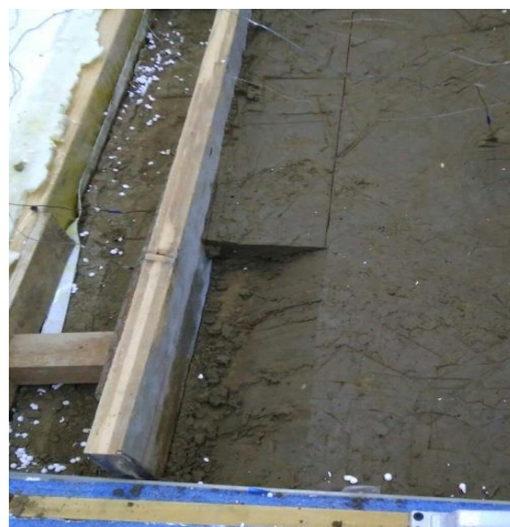
Рисунок 4.17 – Профилирование откосов ЗП автомобильной дороги
