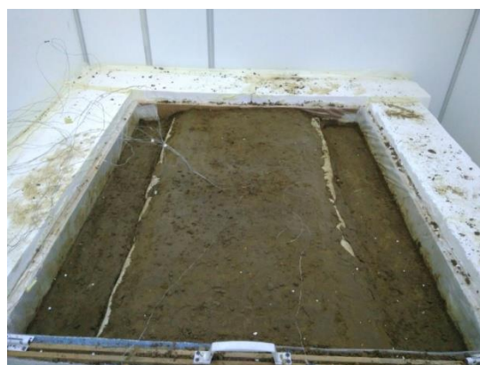
Рисунок 4.27 – Профилирование откосов ЗП автомобильной дороги
