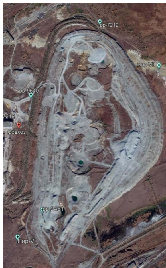
Рисунок 2.7 – Состояние земной поверхности ш. “Соколовская” в 2017 г.
