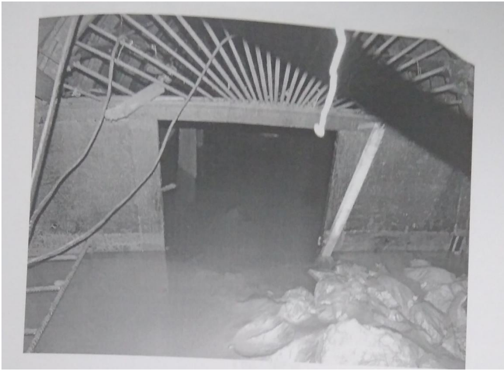
Рисунок 1.2 – Последствия прорыва пород на ш. «Соколовская», Республика Казахстан
