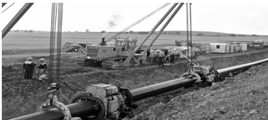
Рисунок 1. Пример масштабности ремонтных работ открытым методом
